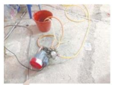
使用加壓馬達注水測試
